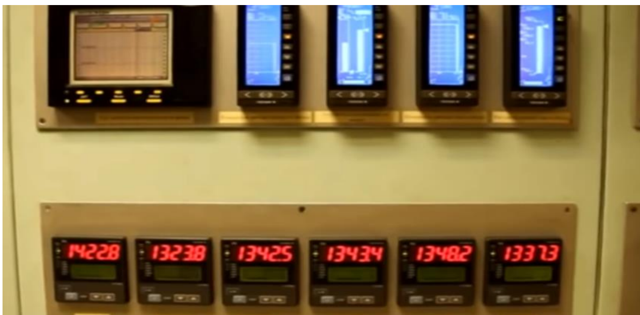
Фото 3 – Система автоматического контроля и регулирования процесса стекловарения
